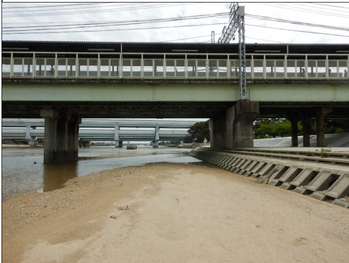
台風 2 号の出水で潮止堰～伊子志堰まで転倒された
