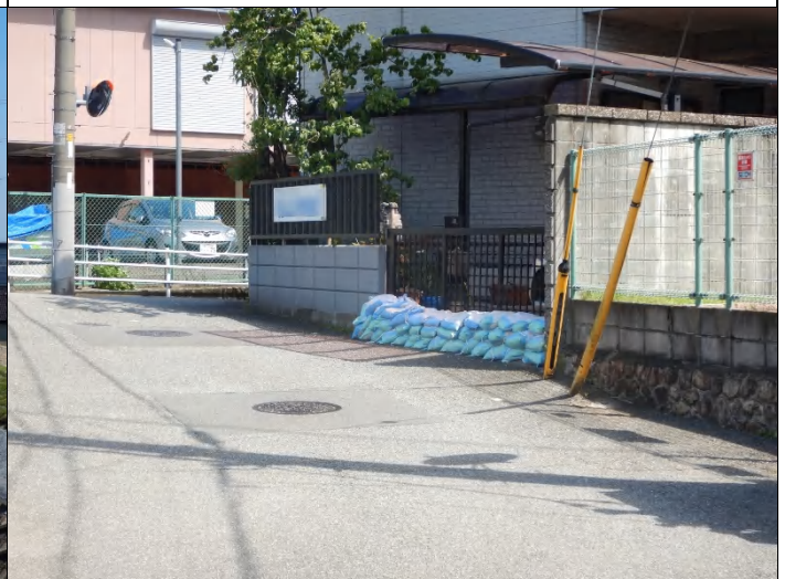
小浜は度々大堀川溢水被害を経験し 2 号台風への備え
