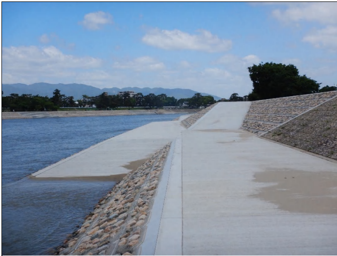
見慣れぬ施設「防災船着場？」 武庫川左岸（大島地区）
