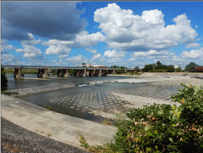
渇水時の3号床止め 8月11日
