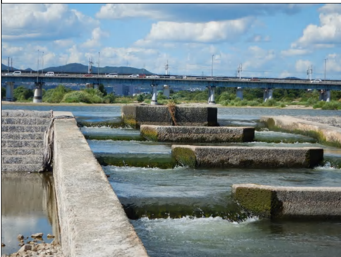
渇水時の5号床止め 8月11日
