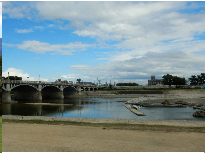
次年度は、武庫大橋下流側の2号床止め改修工事が行われる
