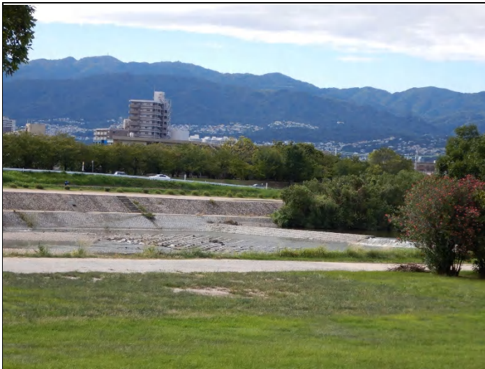
3号床止め 来年は右岸側の工事実施で完成する
