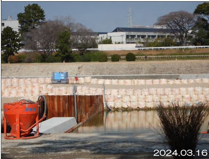
落差工撤去帯工ができた。
