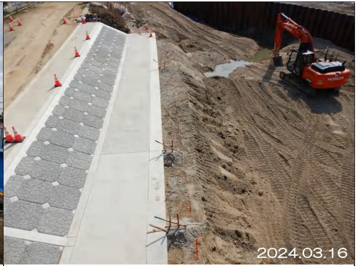
阪神橋梁下拡幅工事全容見えてきた。
