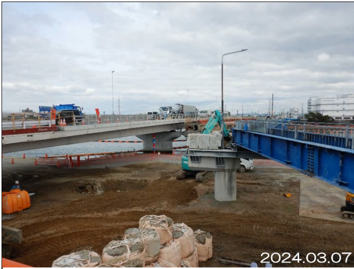
南武橋両岸取り付け部撤去 橋脚杭工事
