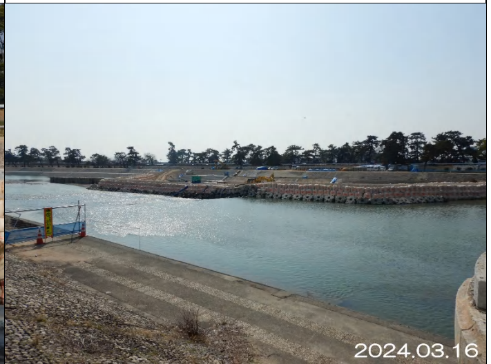
武庫大橋下流右岸 土嚢撤去したら上流側と同じ風景になる
